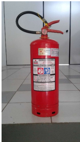
Figura 9: extintor PQS 08 kg. Fonte: autores (2019).
