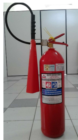
Figura 6: extintor CO2 06 kg. Fonte: autores (2019).
