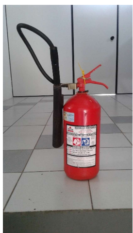
Figura 5: extintor CO2 04 kg. Fonte: autores (2019).
