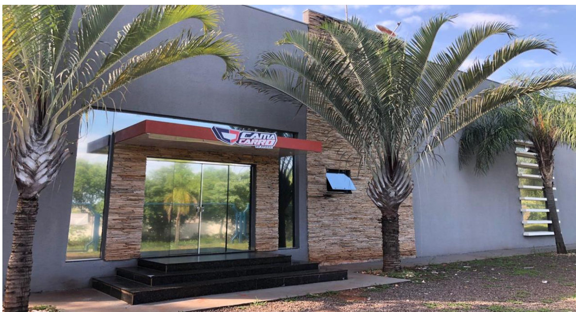
Figura 01: Fachada da empresa Cama Carro. Fonte: Autores (2020).
