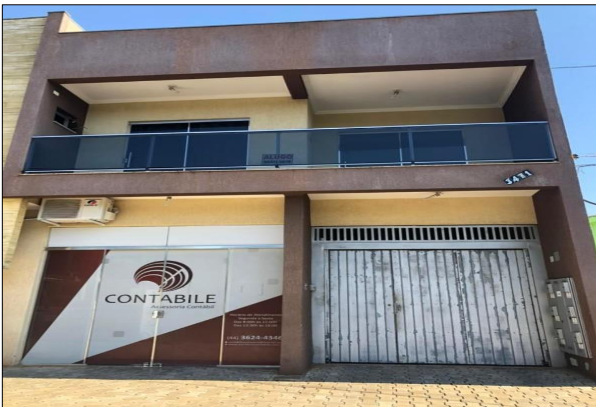
Foto 01: Vista externa do empreendimento.
