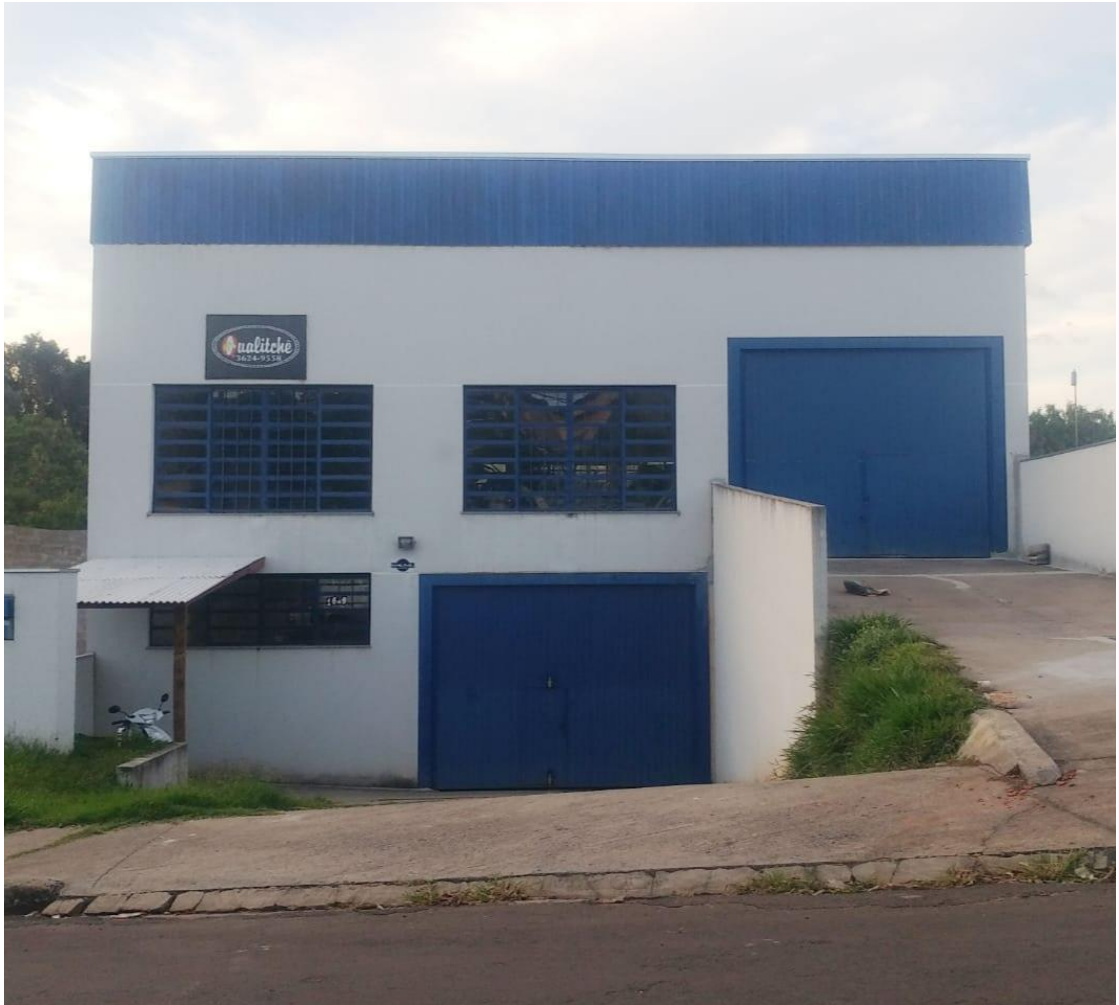
Figura 01: Vista frontal da instalação, somente o andar inferior. Fonte: Imagem capturada pelos autores, (2021).
