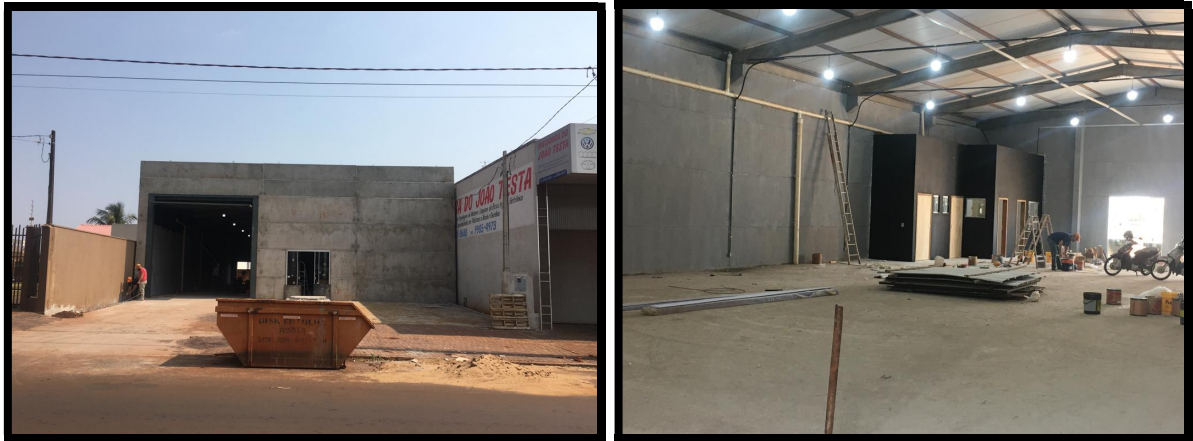
Figura 01 – Instalação da empresa.
